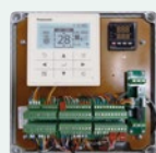
PCB, stærkstrømstransformer, klemrække
